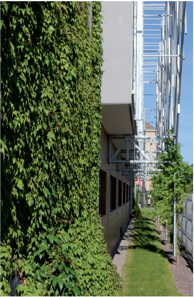
Bodengebundene Fassaden- und Rankgerüstbegrünung
